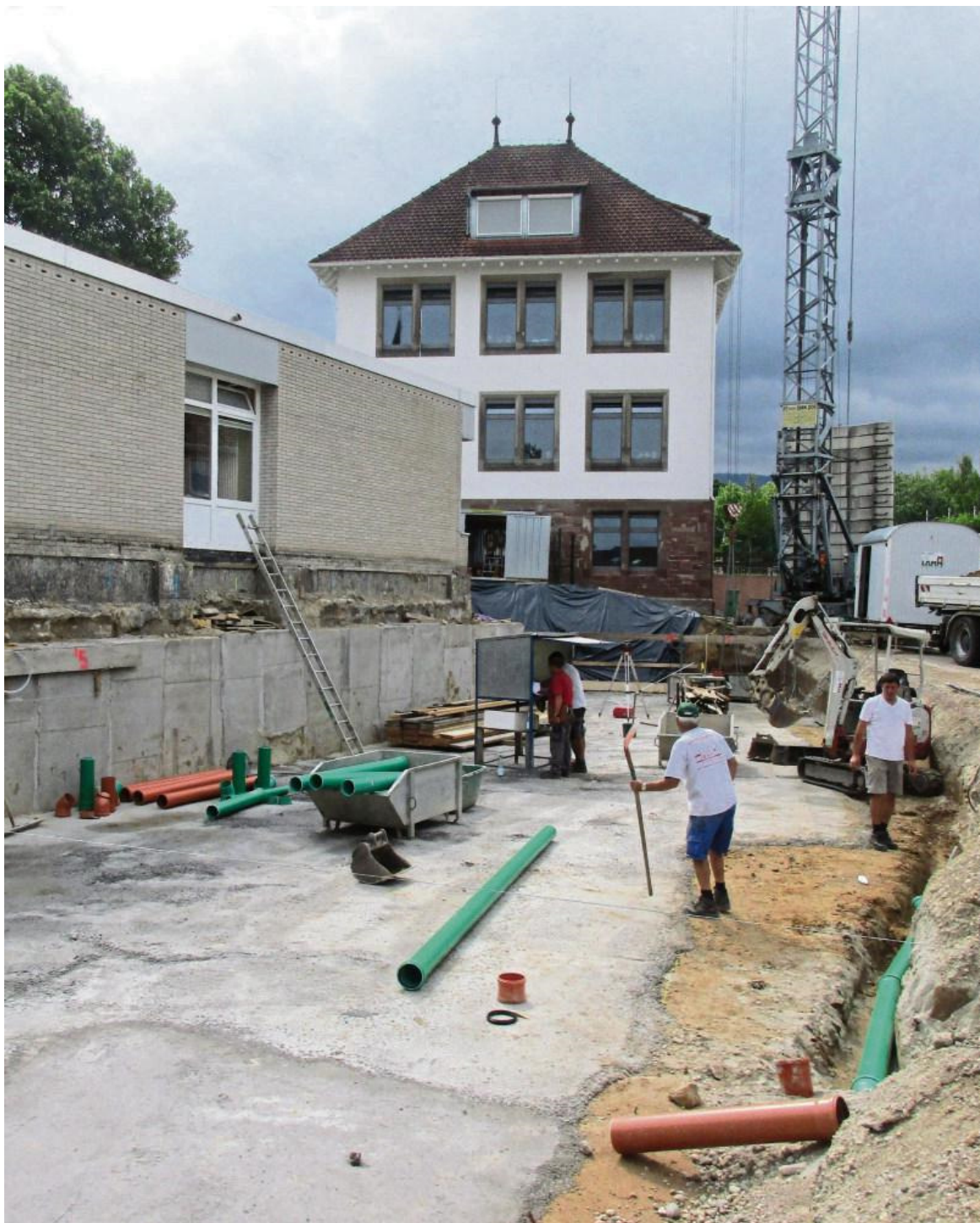
DAS FUNDAMENT STEHT: Der Erweiterungsbau des Kindergartens „St. Michael“ soll im November fertiggestellt sein. Foto: jfr
