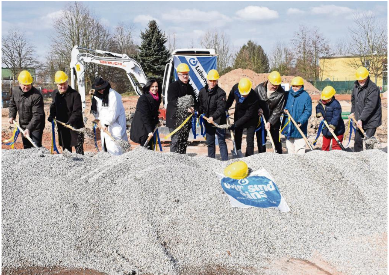
ERSTER SPATENSTICH: Wo früher Tennis gespielt wurde, sollen bald Menschen mit Behinderung aus der Lebenshilfe-Wohnstätte Steinbach eine neue Heimat bekommen. Nun feierten unter anderem Vertreter der Lebenshilfe, der Striebel-Stiftung und der Baufirma den Baubeginn. Fotos: Gabriel
